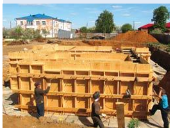
Закладка фундамента храма
