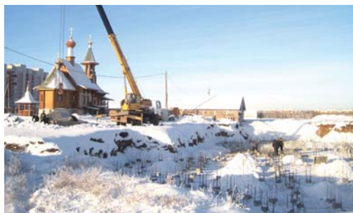
Возводится фундамент храма
